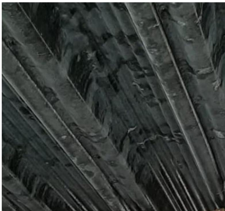
**Foto 08:** Localizada na cobertura do mercado 01 (açougue). Oxidação nas telhas, alguns furos, amassamentos e a presença de lixiviação.
