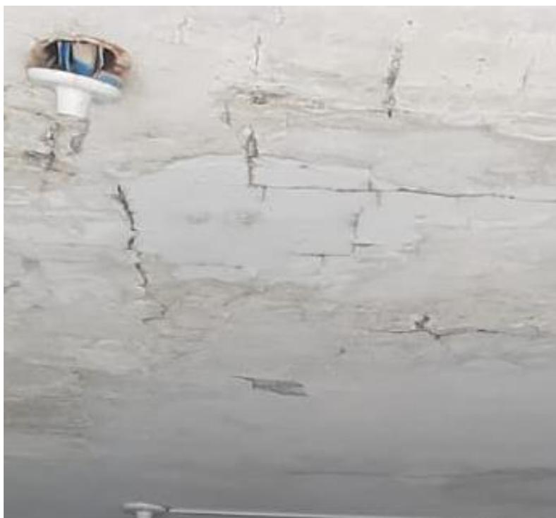
**Foto 09:** Laje de cobertura localizada no bloco central. Corrosão de armadura e manchas de umidade.
