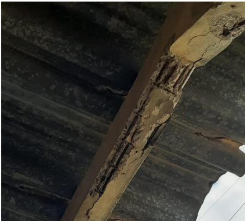
**Fotos 03:** Nesse ponto, apresenta Corrosão de armadura mais crítica, manchas de umidade e de corrosão.
