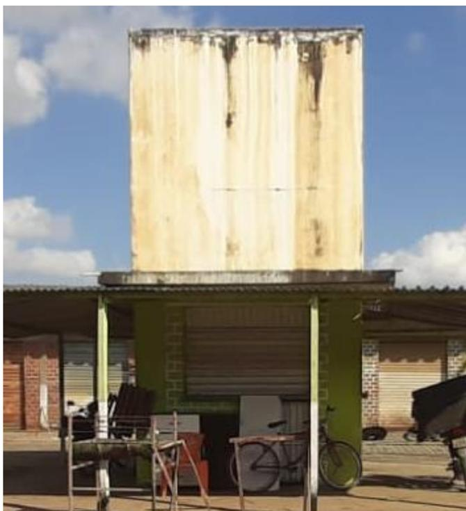
**Foto 11:** Manifestação localizada no Reservatório superior em laje de cobertura do bloco central, apresentando sinais de reparação anteriormente realizada. Corrosão de armadura, manchas de umidade
