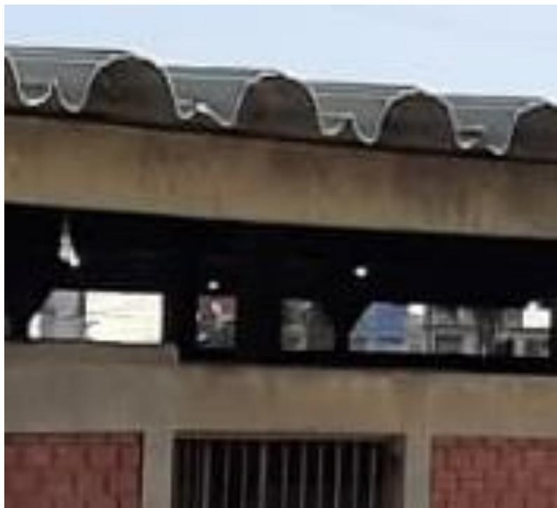
**Foto 02:** No geral não apresenta manifestações críticas, apenas pequenas fissuras. Manchas de umidade e de corrosão
