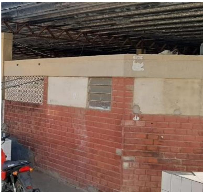
**Foto 04:** Pontos de infiltrações e ausência de reboco. Manchas de umidade e de corrosão.
