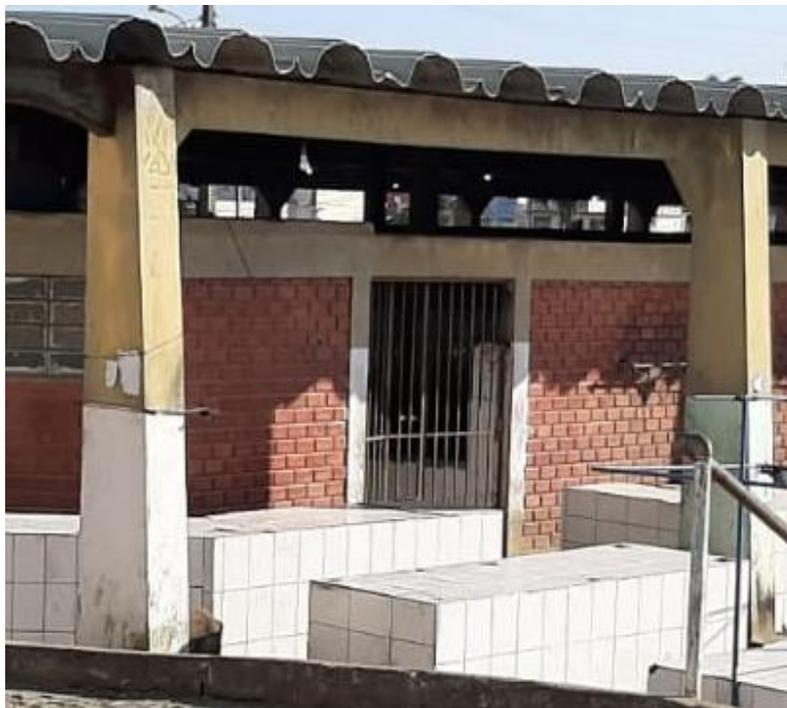
**Foto 01:** Manifestação de pequenas fissuras, aparentemente por dilatação da argamassa. Manchas de umidade e desgaste por falta de manutenção.
