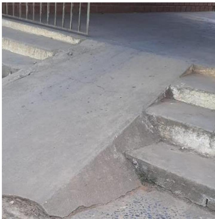
**Foto 15:** Rampas com inclinação inadequada de acordo com a NBR 9050/2020
