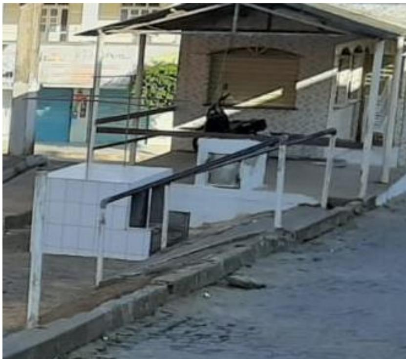
**Foto 10:** Reservatório inferior. Localizado do lado esquerdo do açougue. Falta de manutenção.
