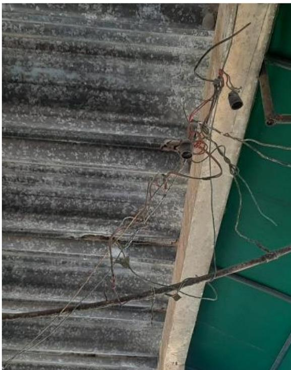
**Foto 14:** Fiação elétrica exposta e instalada de forma inadequada acarretando risco de curto e incêndio.
