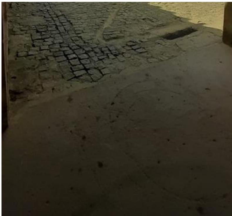
**Foto 05:** Desgaste rejunte pelo uso e tempo e alguns pontos de infiltrações. Piso interno
