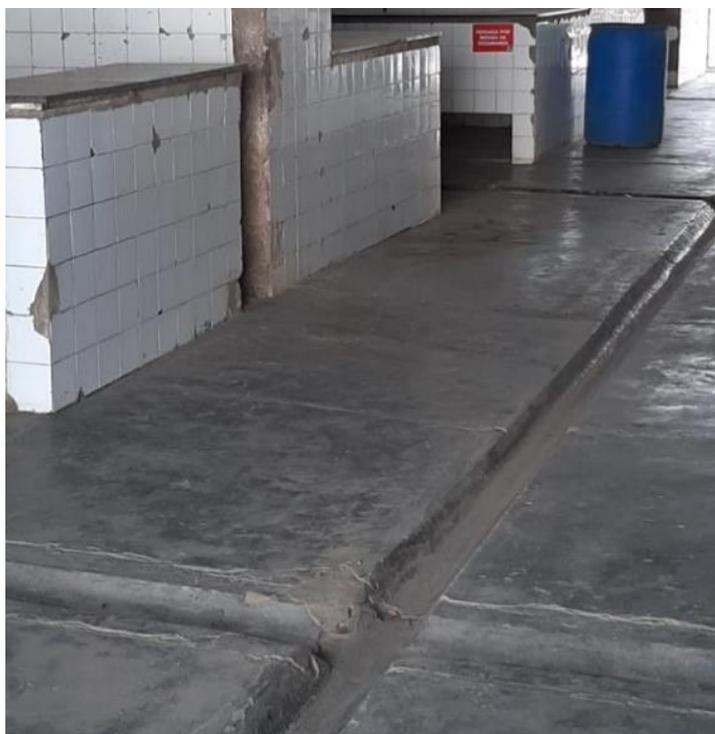
**Foto 13:** Valas de escoamento superficial de forma inadequada.
