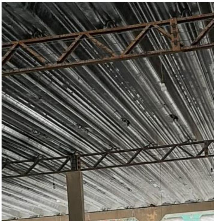
**Foto 07:** Corrosão das treliças, sinais de oxidação. Localizada na cobertura do mercado 01 (açougue).
