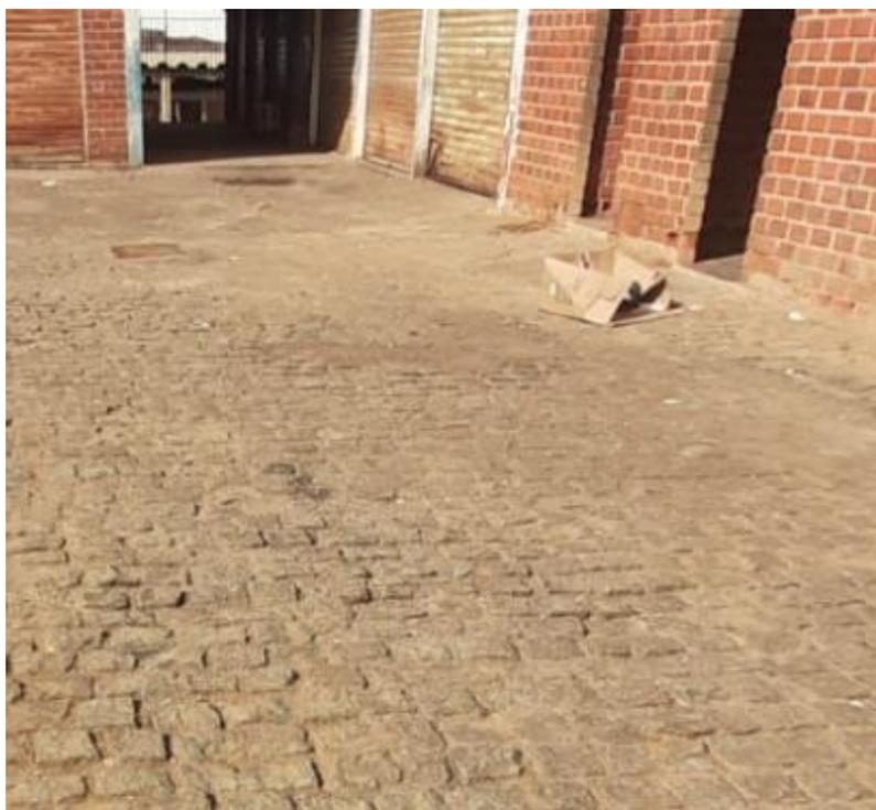
**Foto 06:** O piso externo em paralelepípedo encontra-se em condições precárias com irregularidades, abaulamentos e falhas.
