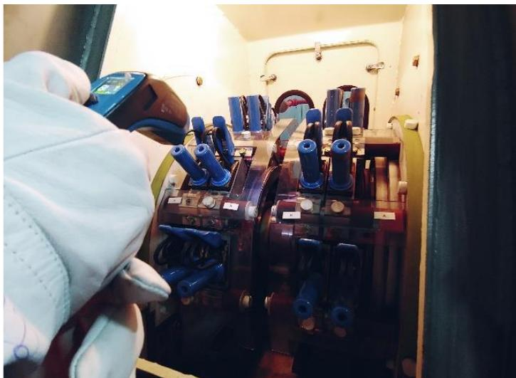
**FIGURA 5** - Medição de temperatura do anel
