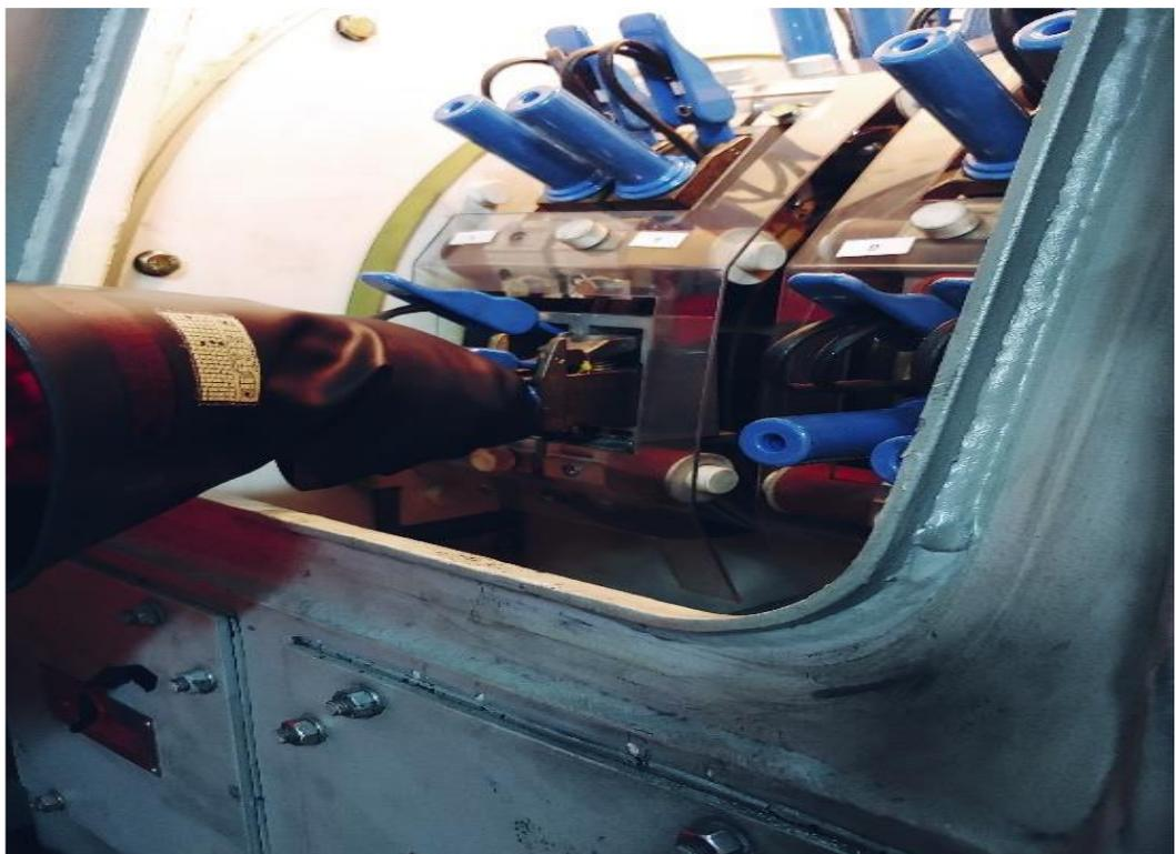
**FIGURA 9** - Retirada da escova. Puxe lentamente com a manopla pressionada.
